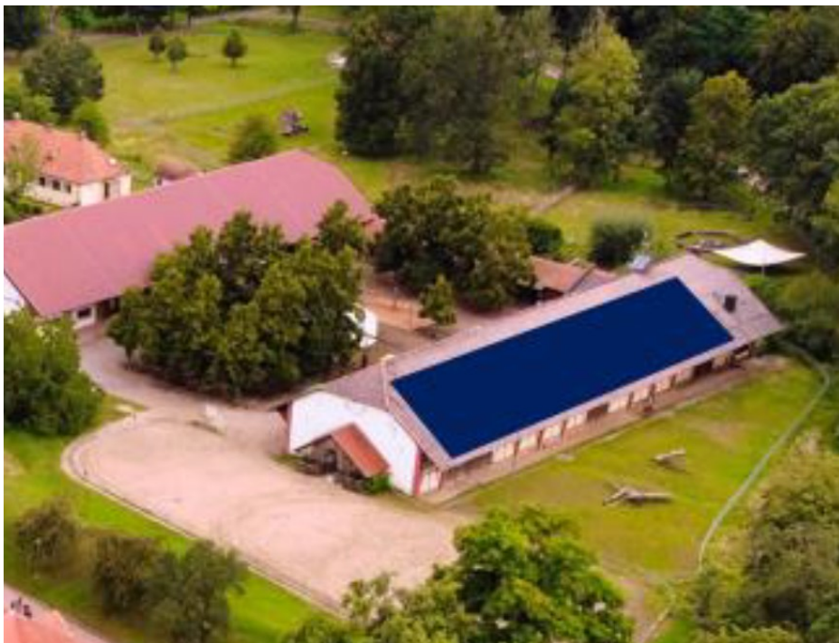
Abbildung 2: Visualisierung der bereits installierten Anlage auf der KonTiKi-Scheune (Ost-Teil)
