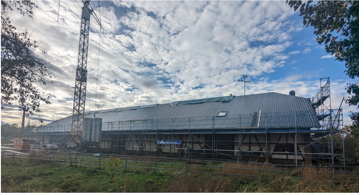
Abbildung 3: Dachsanierung der KonTiKi-Scheune
