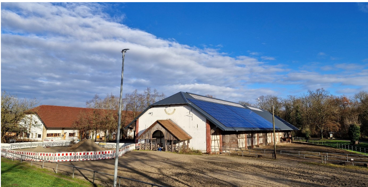
Abbildung 4: Ostseite der KonTiKi-Scheune mit installierter PV-Anlage. Links die Baustelle für den Leitungsanschluss.
