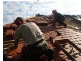
Abbau vom alten und Eindecken vom neuen Werkstaddach mit vielen Helfern
