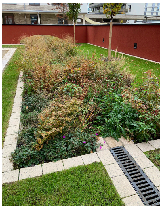
Abb. 37: vielfältig bepflanztes Verdunstungsbeet zur Aufnahme von Regenwasser [3]
