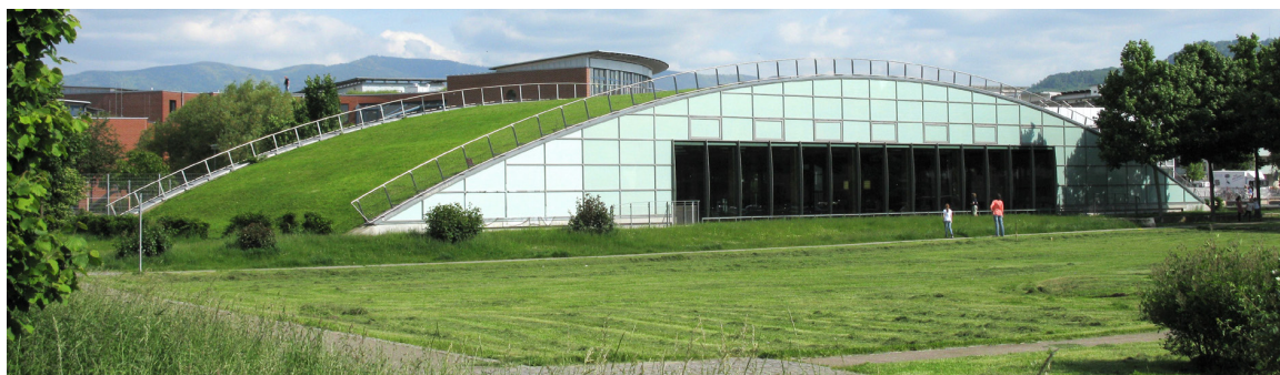
Abb. 41: Spektakuläres Gründach der Clara-Grundwald-Turnhalle im Rieselfeld reduziert sommerliche Gebäudeaufheizung [1]
