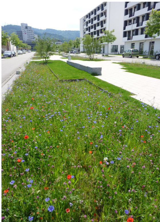
Abb. 98: Straßenentwässerung der Eugen-Martin-Straße in Form einer flachen Mulden Güterbahnhof Nord [1]
