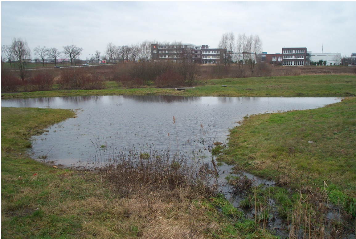
Abb. 66: Als Teich naturnah ausgestaltetes Regenrückhaltebecken [4]
