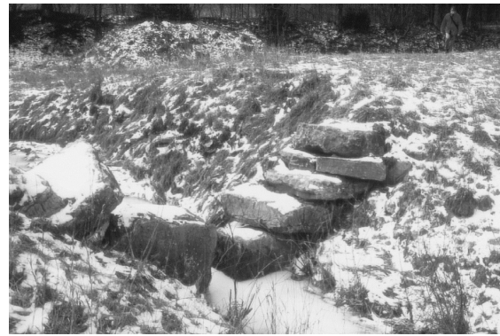
Abb. 122: Auslassbauwerk eines Kleinspeichers als Blocksteindrossel (Foto: André Assmann)
