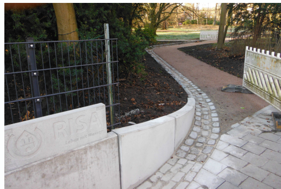
Abb. 89: Als Notwasserweg für die angrenzende Straße modellierter Parkweg mit abgesenktem Überlauf in Rasenfläche. Untere Stufe rasenbündig [3]
