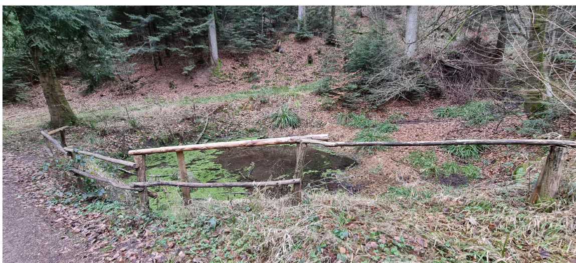
Abb. 134: Retentionsmulden am Hang bei St. Ottilien dämpfen Abflussspitzen der Bergbäche [1]
