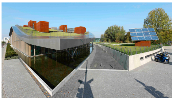
Abb. 59: Auch Extensives Gründach mit Rasen erfordert Bewässerung und intensive Pflege [4]
