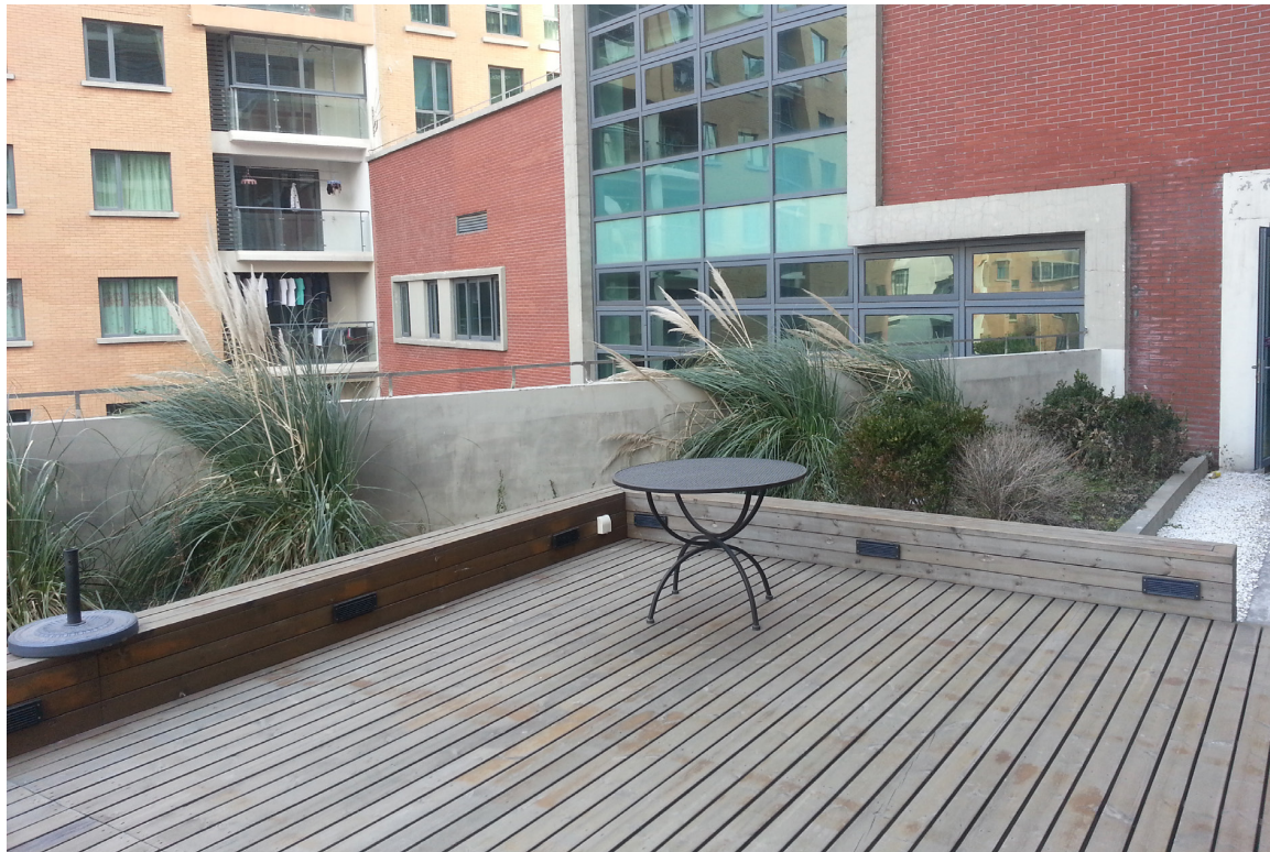
Abb. 62: Intensives Gründach in Kombination mit einer Terrassennutzung [4]
