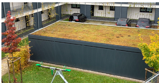
Abb. 42: Dachbegrünung auf einem Garagendach [3]
