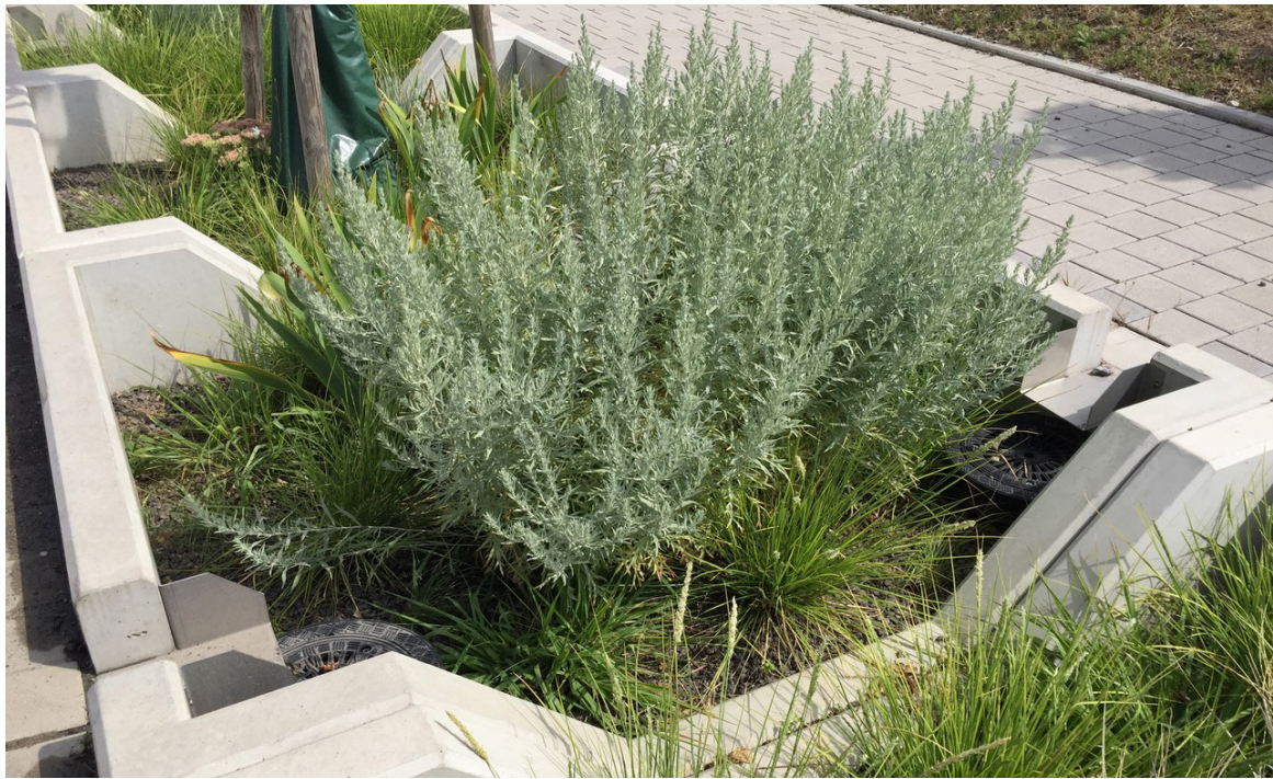
Abb. 49: Tiefbeete mit oberirdischem Zulauf im Gewerbepark Taylorpark-Barracks in Mannheim [4]
