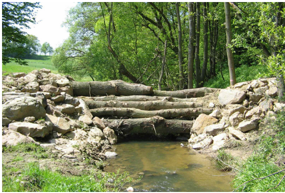
Abb. 121: Kleinste Stauanlage „Biberdamm“ verzögert Hochwasserspitzen an Bergbächen (Foto: Kreisverwaltung Schwalm-Eder)
