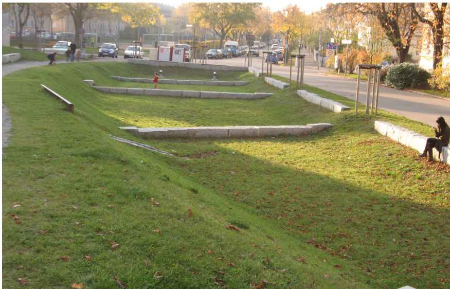
Abb. 96: Semizentrale Mulden-Rigole Peter-Sprung-Str./alter Wiehrebahnhof [1]
