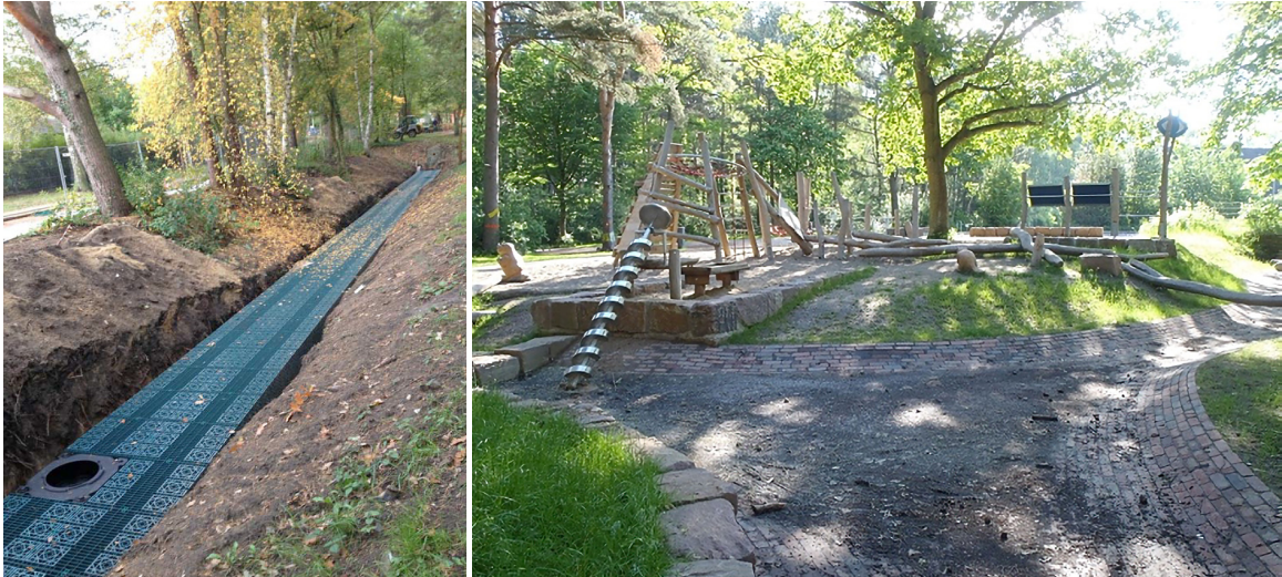
Abb. 116: Regenspielplatz Haferacker – Multifunktionale Nutzung eines Spielplatzes zur Starkregenvorsorge: Links: Einbau von Rigolen in den erweiterten Sickergraben; Rechts: Spielplatz mit Flutmulde (Fotos: HAMBURG WASSER)
