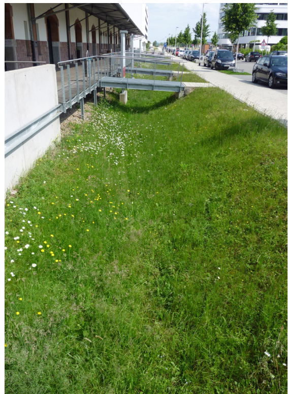
Abb. 99: Muldengraben zur Versickerung Alter Zollhof Güterbahnhof Nord [1]
