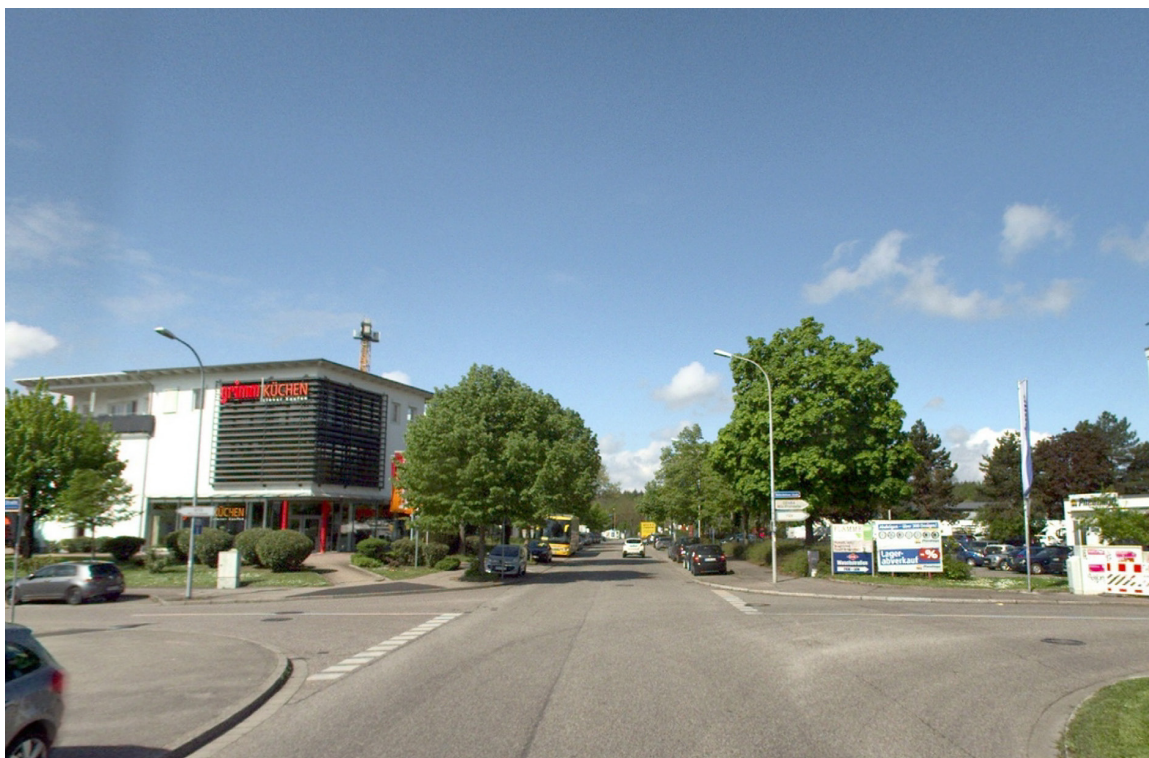
Abb. 91: Die Munzinger Straße soll beim außergewöhnlichen Starkregen als Notwasserweg in den Mooswald dienen [1]
