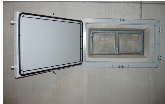
Abb. 93: Druckfeste Abdichtung Kellerfenster (Foto: IBS Technics GmbH)
