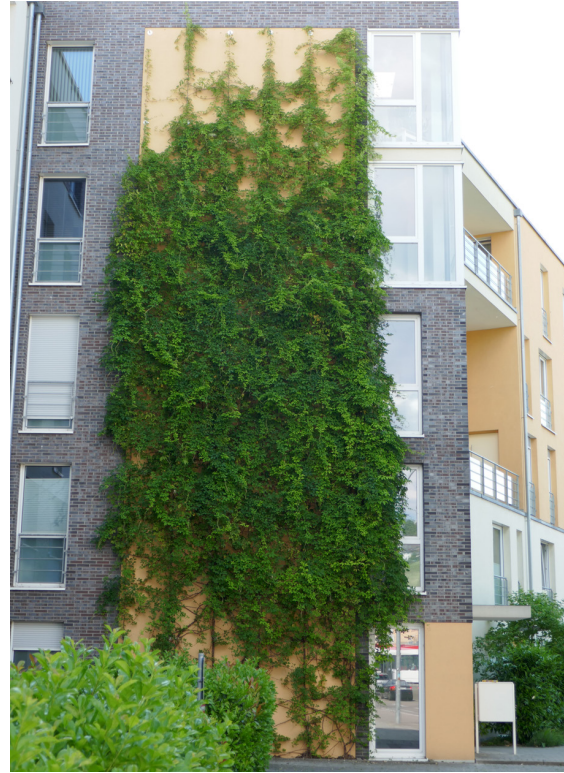
Abb. 46: Gut entwickelte Fassadenbegrünung, begrenzt durch Kletterhilfen, im Vauban [1]
