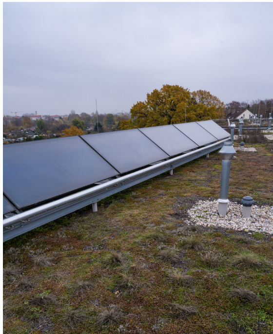
Abb. 68: Regen- und Energiespeicher: Eine Solaranlage auf dem Retentionsdach der Flüchtlingsunterkunft in der Chris-Gueffroy-Allee in Berlin (Foto: Berliner Regenwasseragentur/Andreas [FranzXaver] Süß)
