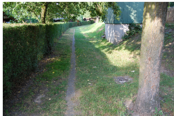
Abb. 79: Grabenstruktur als Zuleitung zu Rigole [4]
