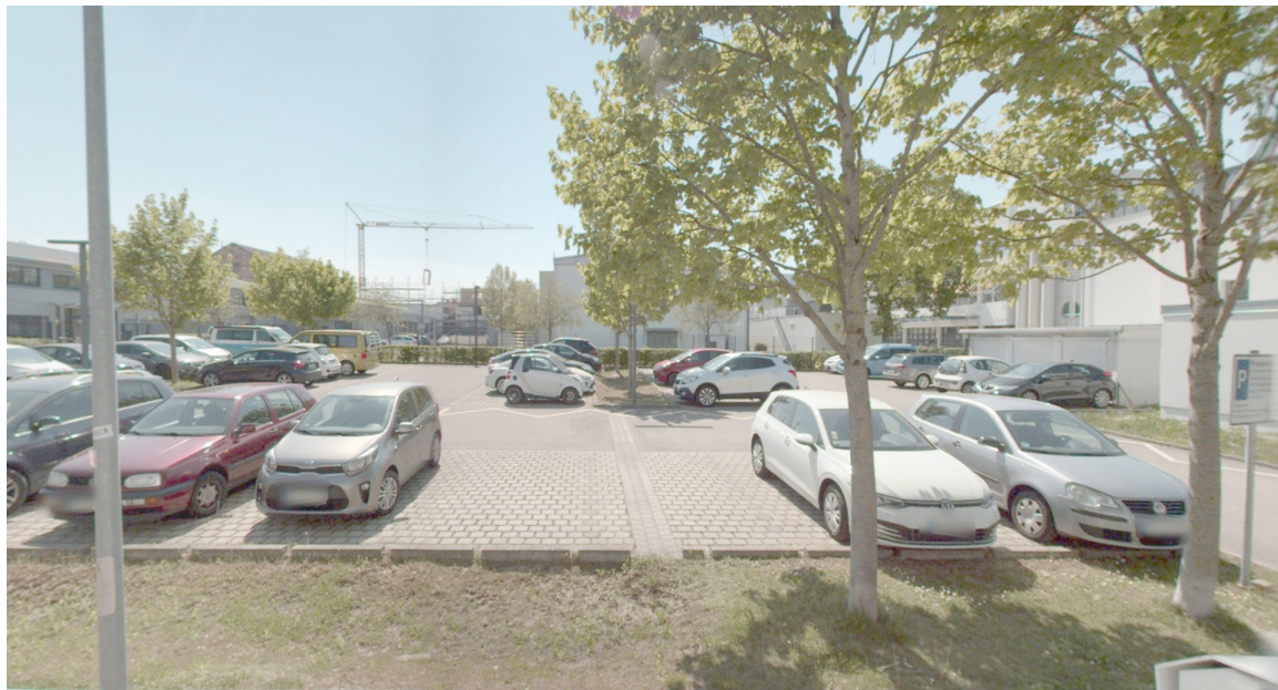
Abb. 48: Gut gelöst - Versickerungsmulde mit auf Lücke gesetzten Hochborden und integrierter Baumpflanzung auf einem Parkplatz im Freiburger Industriegebiet Nord [1]
