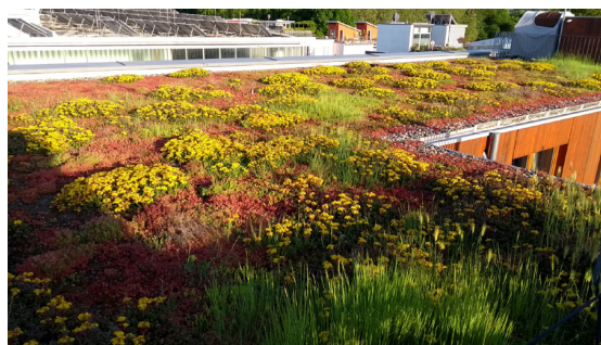
Abb. 60: Extensives pflegeleichtes Gründach in Vauban ohne Wasserversorgung mit hoher Biodiversität [1]
