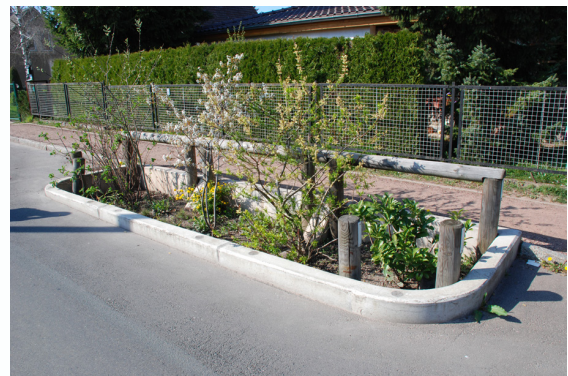
Abb. 50: Tiefbeet im Straßenbereich von Birkenstein mit unterirdischem Zulauf, nahe Berlin [4]
