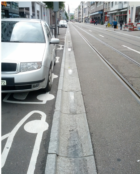
Abb. 87: Straßenentwässerung als Notwasserweg [4]
