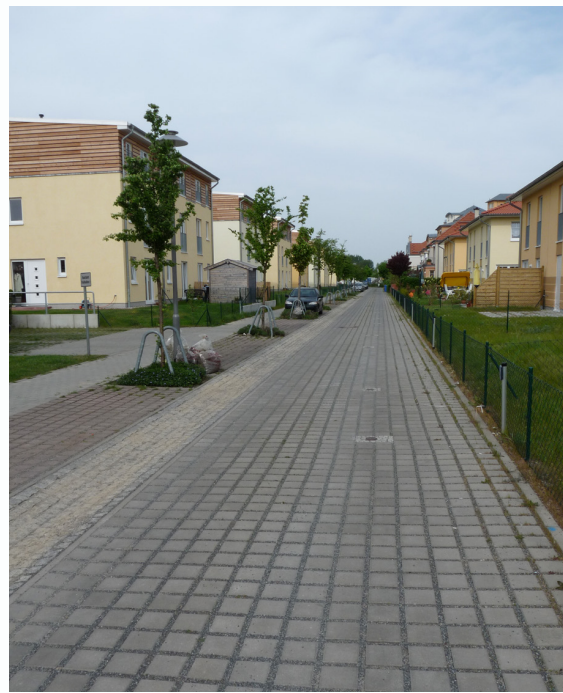
Abb. 88: Notwasserweg im Siedlungsgebiet mit Gefälle und ableitender Pflasterrinne [4]
