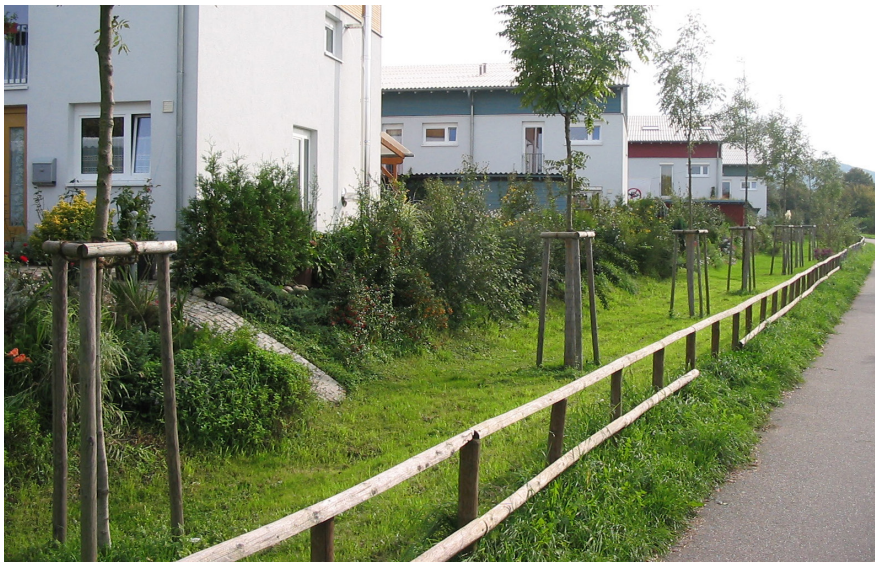
Abb. 95: Versickerungsmulden im Neubauquartier Bugginger Straße [1]
