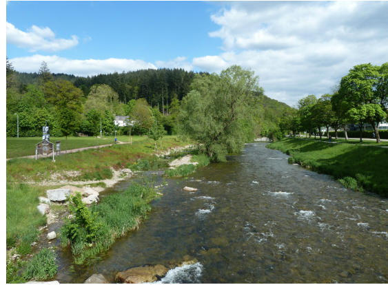
Abb. 125: Renaturierter Abschnitt der Dreisam hat ein zusätzliches Retentionsvolumen zum Hochwasserschutz geschaffen [3]
