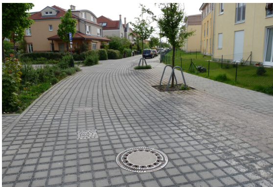
Abb. 55: Durchlässiger Pflastersteine im Straßenraum [4]
