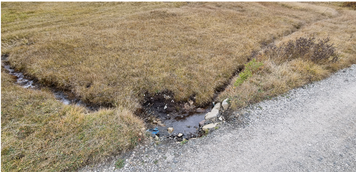
Abb. 143: Kleinstmulde vor dem Durchlass reduziert Überflutung des Wirtschaftsweges [1]
