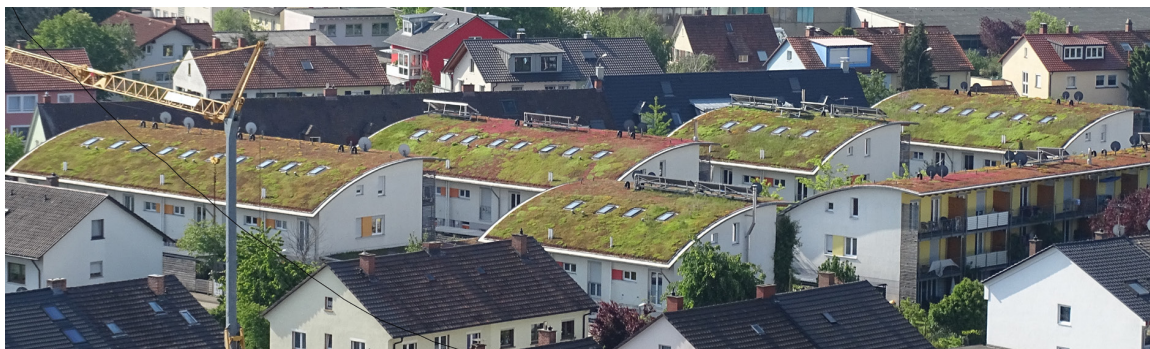
Abb. 61: Auch Tonnendächer sind extensiv begrünbar, hier in FR-Weingarten, ergänzt um Solarmodule [1]
