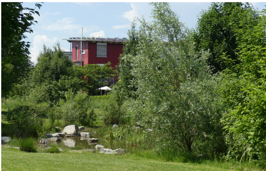
Abb. 97: Versickerungs- und Rückhalteteich in öffentlicher Grünfläche Rieselfeld 4. BA [1]
