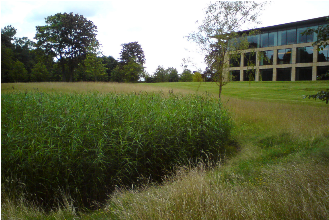
Abb. 74: Mit Schilf bewachsener Retentionsbodenfilter [4]
