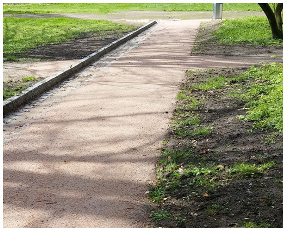
Abb. 90: Hamburg Ohlendorffs Park: Multifunktionale Flächennutzung mit Notwasserweg für die Retention von Starkregen: Um das Wasser zu führen, wurde das Straßenprofil vom Dachprofil zum Querprofil geändert (oben links). Über eine gepflasterte Rinne als Notwasserzulauf / Notwasserweg wird es in und durch die Grünfläche zu einer Senke geleitet (oben rechts und unten links). Die fertiggestellte Gesamtanlage unten rechts aus der Luftbildperspektive (Fotos: HAMBURG WASSER; Digitales Orthophoto/Schrägluftbild © Freie und Hansestadt Hamburg, Landesbetrieb Geoinformation und Vermessung, www.geoinfo.hamburg.de , Datenlizenz Deutschland - Namensnennung - Version 2.0)
