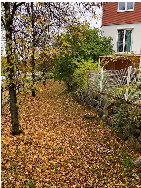
Abb. 57: Bewachsene Versickerungsmulden als Graben [3]
