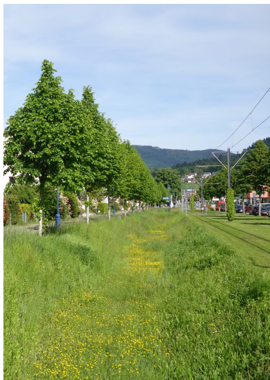
Abb. 53: Schwammstadtflächen im Vauban: Mulden-Rigolen-Versickerung und Rasengleise [1]
